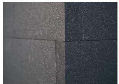
Figuur 3 Thermische isolatieplaten worden continu en verspringend naar boven gelegd, beginnend vanaf de onderkant van de muur. De planken moeten ook op de hoeken verspringend worden geplaatst.
