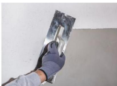
Figuur 1 Istanbul Blue Mineral Textured Decorative Pleister wordt met een troffel op het oppervlak aangebracht
