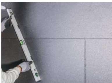
Figuur 2 Isolatieplaten worden aan de muur gelijmd door ze lichtjes te verschuiven, zodat ze volledig contact maken met de muur. Het controleren van de plaatniveaus dient te gebeuren met een meter of waterpas.
