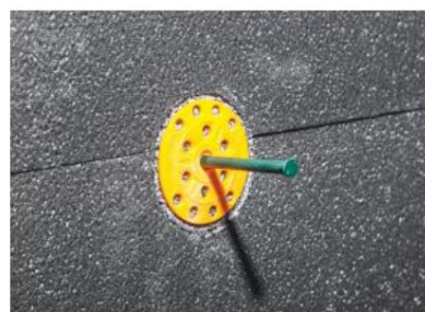
Figuur 3: De deuvels worden in het geopende deuvelgat geplaatst en de deuvelnagels worden volledig ingeslagen.
