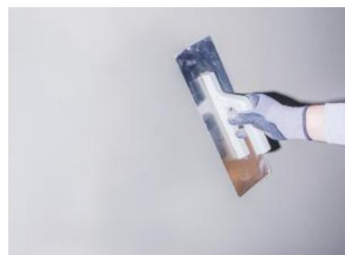
Figuur 3 Afhankelijk van de weersomstandigheden wordt de tweede laag gipsmortel aangebracht door te wachten tot de eerste laag gipsmortel enigszins is uitgelopen.
