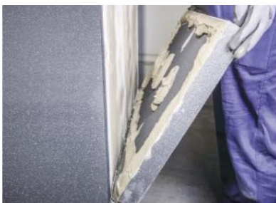
Figuur 1 De thermische isolatieplaat, met aan de achterzijde lijm mortel aangebracht, dient zonder kieren op het ondergrondprofiel te worden geplaatst.
