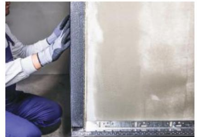
Figuur 3 De maat van de van begin tot eind toegevoegde kelderprofielen, met een afstand van 2-3 mm ertussen, moet worden gekozen in overeenstemming met de dikte van de te gebruiken thermische isolatieplaat.
