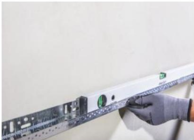
Figuur 1 Installatie van Istanbul Blue Substrate Profile zorgt ervoor dat het bekledingssysteem gebalanceerd en glad is. Om mogelijke krommingen op het oppervlak te corrigeren, worden de gaten, uitsparingen en uitsteeksels tussen de muur en het onderkelderprofiel gecorrigeerd met wiggen van verschillende diktes en wordt het oppervlak vierkant gemaakt.
