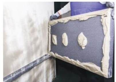
Figuur 3 Bij het aanbrengen van lijm mortel op de achterkant van de thermische isolatieplaat moet erop worden gelet dat deze niet over de randen morst.
